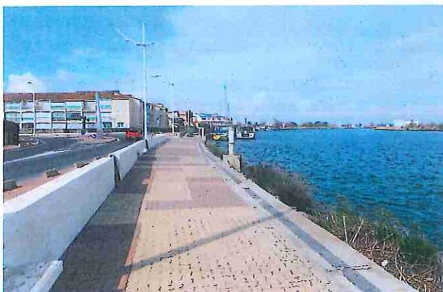
Le muret sera constitué d'une structure en béton armé en forme de T renversé. La longueur du muret sera de 600 mètres pour une épaisseur de 25 centimètres. Sa ligne de crête variera entre 2,10 mètres et 2,70 mètres NGF, sa hauteur variera entre 20 et 130 cm.
